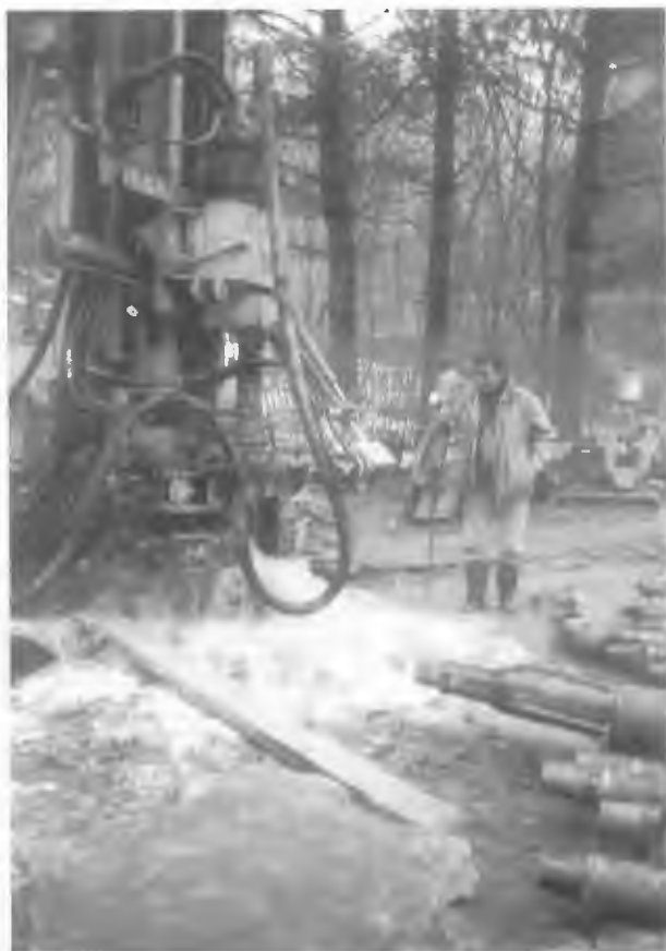
Sl. 2 Samoistjecanje podzemne vode iz bušotine Lo-5 kod Lobora. Fig. 2 Groundwater overflows from the borehole Lo-5 at Lobor.
