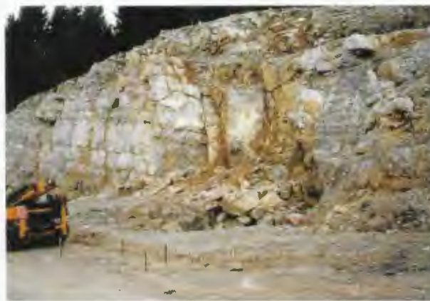
Sl. 3 Rasjedna zona i kaverna, km 63+680. Fig. 3 Fault zone and the cave, km 63+680.
