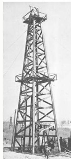
*Slika 1. Proizvodna bušotina s drvenim tornjem na naftnom polju Gojlo, 1950*
