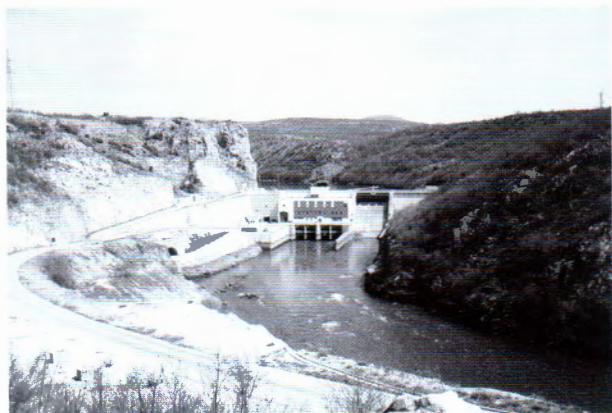
Sl. 15 Hidroelektrana Đale.
