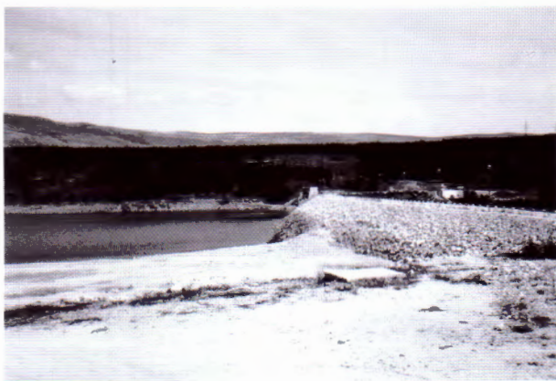
Sl. 19 Brana hidroelektrane Peruća nakon obnove.
