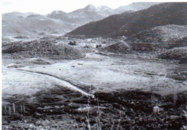
Sl. 5 Kanal matice prema odvodnom tunelu u Krotuši.
