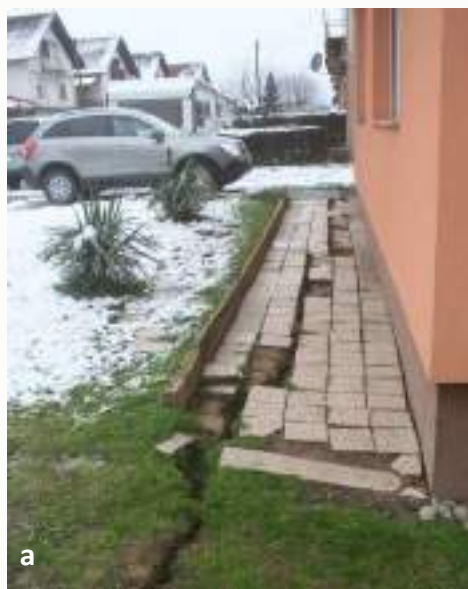
Slika 4: Primjeri pukotina u tlu nastalih uslijed bočnog širenja: a) na području Gline, b) na području Siska
