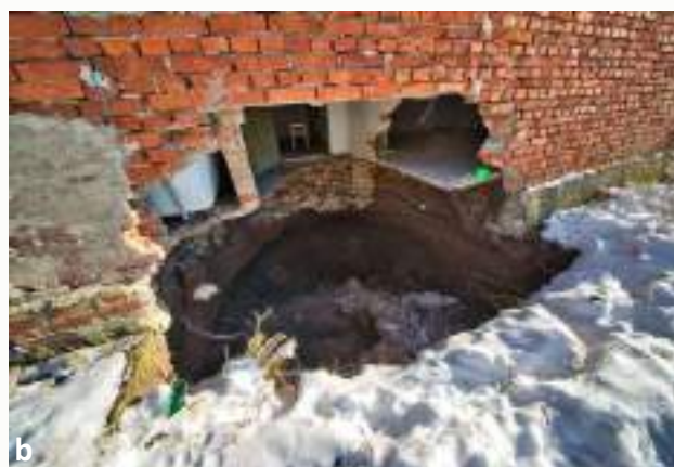
Slika 5: Primjeri urušnih vrtača na području Mečenčana (foto: Tihomir Frangen): a) usporedba zračne i terenske fotografije vrtače između kuća, b) vrtača formirana ispod temelja objekta
