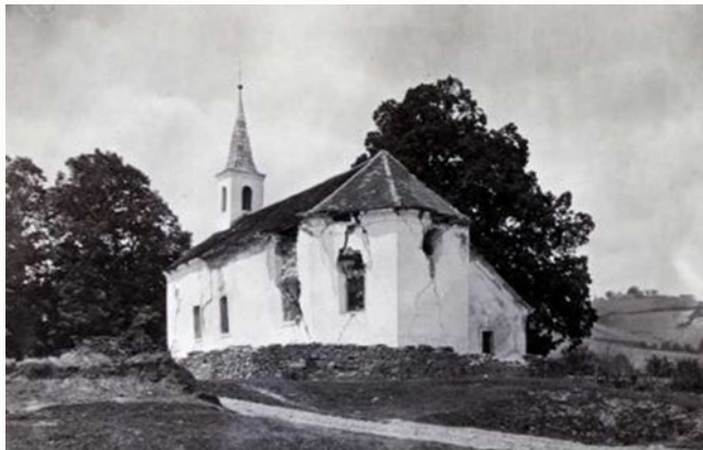
Slika 2. Crkva u Kašini s vidljivim znatnim oštećenjima nakon potresa ( https://hr.izzi.digital/DOS/776/19784.html )
